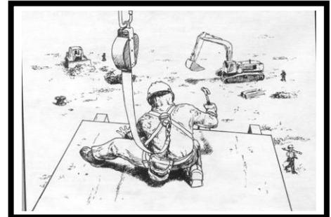
Quando se utiliza este sistema debe estar conectada al anclaje capaz de soportar 5.000 libras. por trabajador sujeto, a menos que el sistema se ha diseñado, instalado y utilizado bajo la supervisión de una persona calificada.
